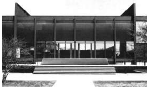
(1.3.) Illinois Institute of Technology, Crown Hall, Chicago, 1952-56., arhitekt: Mies van der Rohe, glavni ulaz, čelična struktura sa ispunom
