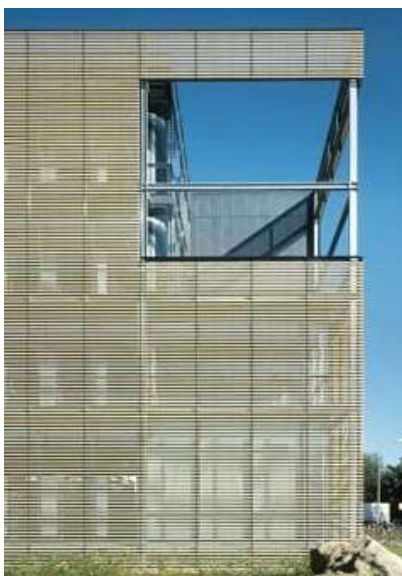
(7.34.) Library University of Cambridge Faculty of Law, 1990-1995, arhitekt: Norma Foster, lamele na pročelju sprječavaju izravnu svijetlost u prostoru
