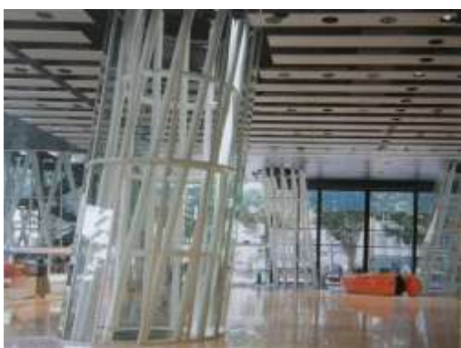
(13.7.) Projekt za medijateku Sendai 1997, arhitekt: Toyo Ito, stupovi nalik na „snopove pruča“
