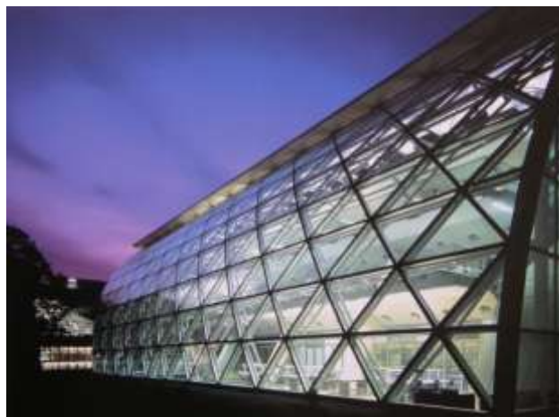
(7.31.) Library University of Cambridge Faculty of Law, 1990-1995., arhitekt: Norma Foster, sferna staklena membrana dijagonalnog rastera
