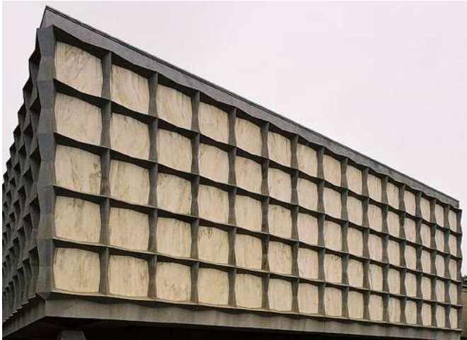
(8.16.) Rare books and manuscripts library, sveučilište Yale, New Haven, natječaj 1960, Gordon Bunshaft /SOM, križni skelet obložen sivim granitom tvori trodimenzionalnu fasadu s ispunom od prozirnih mramornih ploča
